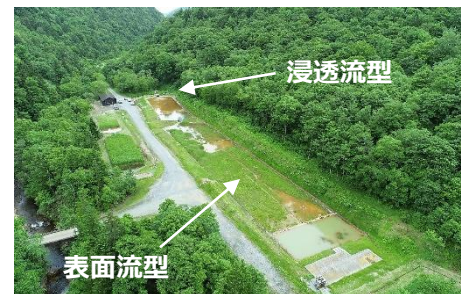
人工湿地坑廃水浄化システム（全景）
