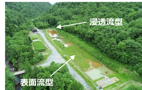
人工湿地坑廃水浄化システム（全景）
