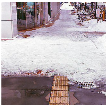
写真1 雪に埋もれて見えなくなった誘導ブロック
