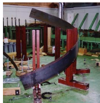
写真3 らせん形の型（鉄板を使用した例）
