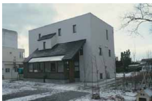
写真8 北面の風除室
