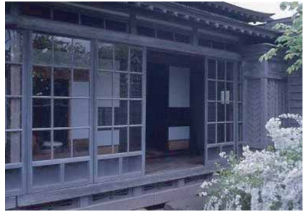
写真3 縁側のある古い住宅
