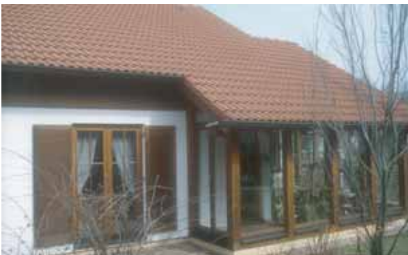
写真7 壁のガラス張り
