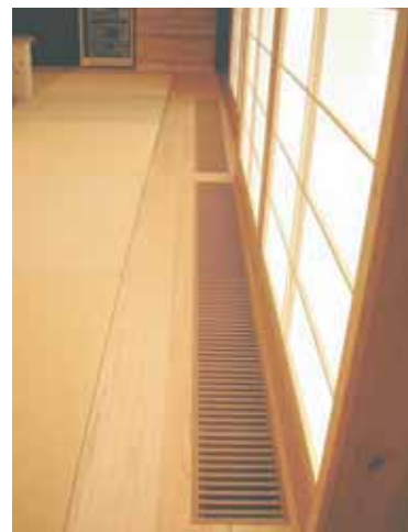
写真2 窓からの冷気流を抑えるガラリ
