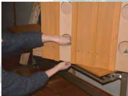
・土台とパネルをボルトにて接合する
