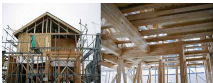
写真3 カラマツを構造材に用いた住宅(外観・内部)
