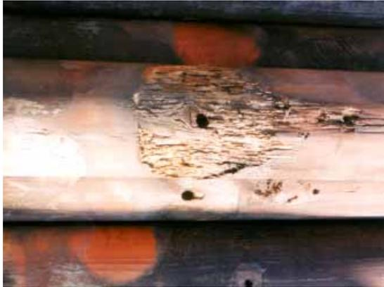
屋外遊具の組み合わせ部分の腐朽
