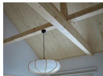
写真1 内装用針葉樹合板の施工例
