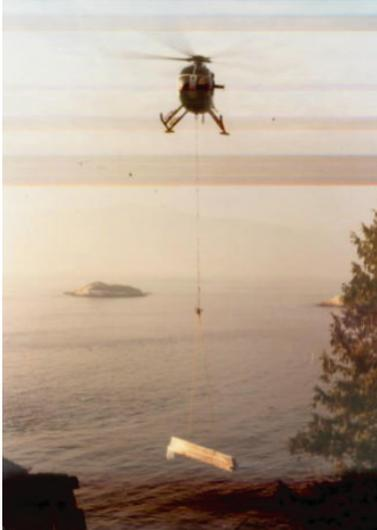
写真7 ヘリコプターによる建材運搬
