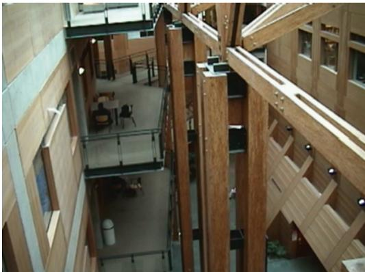
写真1 大学内で使用されている構造用集成材
