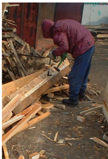
写真1 人手による釘抜き作業
