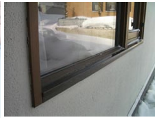
写真10 下枠のアルミ被覆
