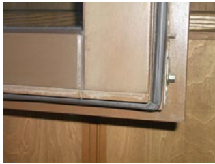
写真16 角に切れ込みを入れた気密材
