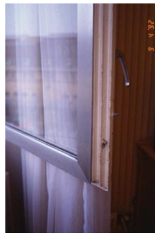
写真11 木とアルミの 複合サッシの例
