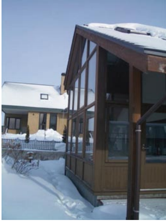
写真8 軒の出が少 なくかつ西面の窓
