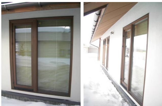
写真7 木製サッシの施工例
