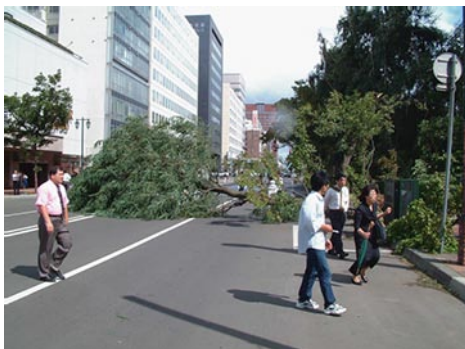
写真 1 道路に倒れて交通障害を発生させた樹木
