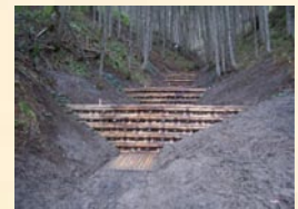
現地間伐材も一部 使用した土留工群 (公共土木事業等における 間伐材の利用拡大)
