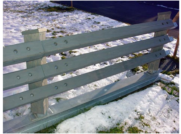
写真1 試作した木製ガードレール（前面）
