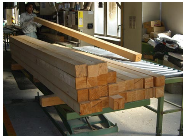
写真 材面を見ながらの荒削り作業
