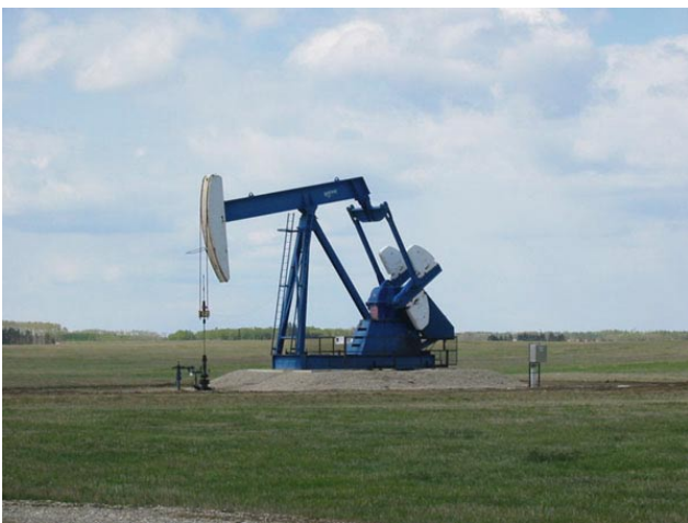
図4 農地で石油をくみ上げるポンプ（2004年5月撮影）
