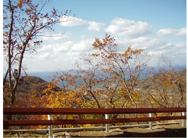
八雲町内の林道への施工
