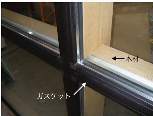
写真10 ガスケット木複合カーテンウォール
