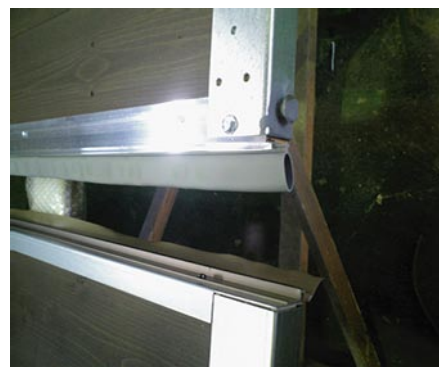
写真11 金属カバーとゴムのシール材
