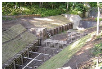
耐久性予測手法を用いて設計・施工された構造物
