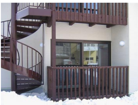
グループホームでの施工例（外観）
