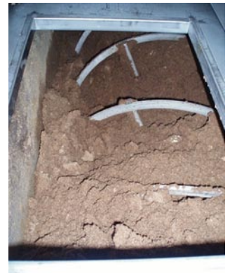
写真4 正和電工社内に設置されているバイオトイレ分解槽の攪拌状況（写真：正和電工(株)提供）
