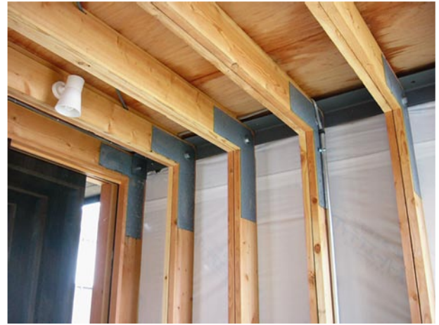
写真4 j-pod 内部構造
