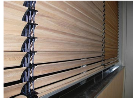
写真4 木製ルーバーの試作（ビル）
