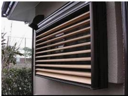
写真3 木製ルーバーの試作（住宅）
