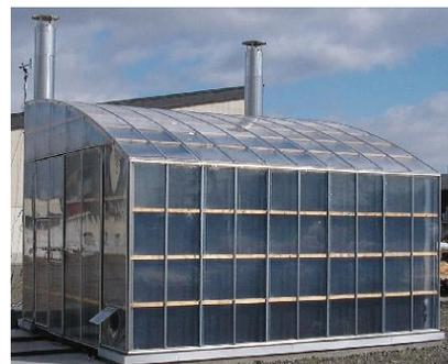
開発したものです。これはコンクリートの床に鋼材で骨組みを造り、その骨組みを挟むように三重構造のビニールフィルムを張っています。また、乾燥室内の内側には炭素繊維のシートを全面に張り、太陽熱を集める効率を高めています。大きさは間口 4.5m、奥行き 5m、高さ 3.8m で、室内空気を循環させるためのファンを備えています。室内空気を排気するための円筒は断熱構造になっていて、これにより電動ファンを使うことなく乾燥室内の空気を排出することができます。
