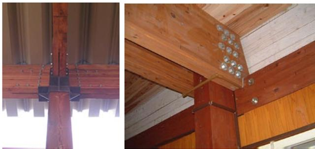
写真2 鋼板挿入接合・合わせ梁の例
