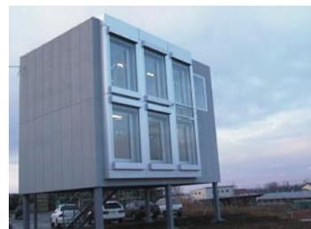
写真 ダブルスキンの実験棟
