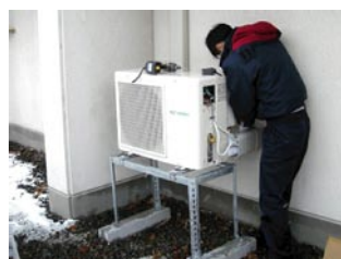
写真1 空気採熱型ヒートポンプ熱源機
