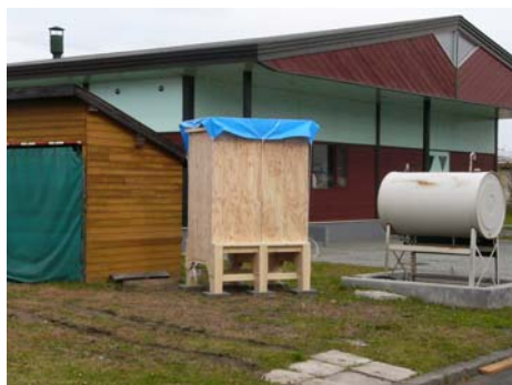
木造サイロ（写真中央）の外観
