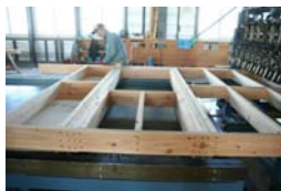
壁組のプレフレーミング
