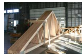
屋根組のプレフレーミング
