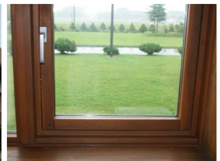
室内側（林産試験場庁舎）
