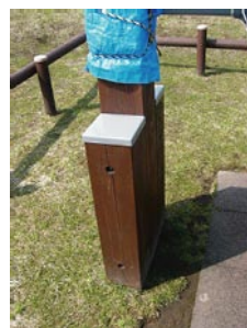
写真8-1 異種素材による木口保護例1
