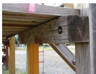
写真7 劣化状態が見えない床と梁の取り付け
