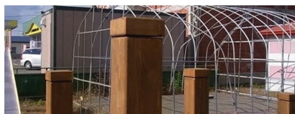
写真9 アセチル化木材による木口の保護
