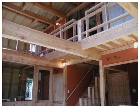
札幌市内に建設の地域材を使用した住宅
