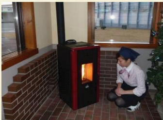
ペレットストーブ設置
