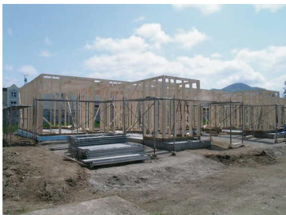
写真2 建設中の敷島団地
