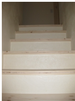
写真2 階段踏み板の例
