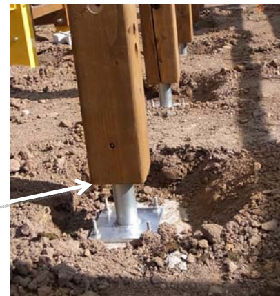
柱脚金物の施工状況
