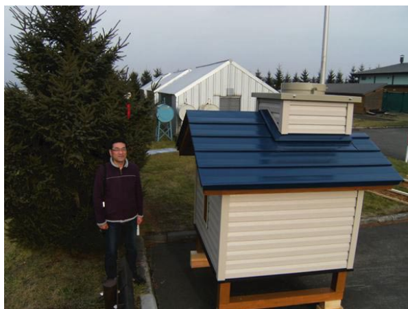
写真5 木造サイロ（二次試作） 容量 1,000kg未満（1,350×1,350×800mm）
