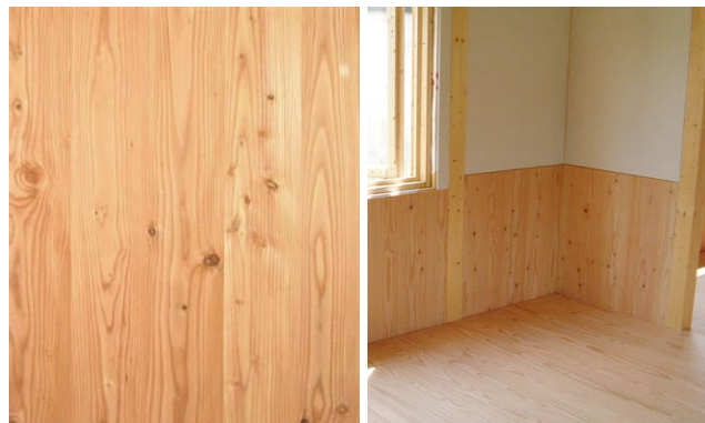
写真4 内装用に開発したカラマツ合板と 腰壁への利用例
