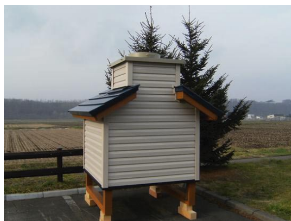
写真5 木造サイロ（二次試作） 容量 1,000kg未満（1,350×1,350×800mm）
