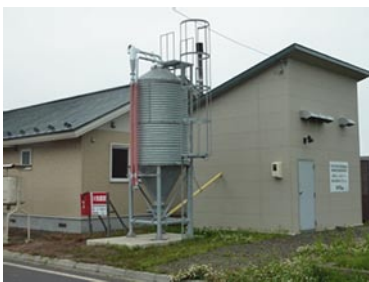
写真5 サイロの外観 (鋼コルゲート製)
