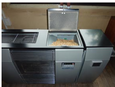
写真2 ペレットストーブのタンク
