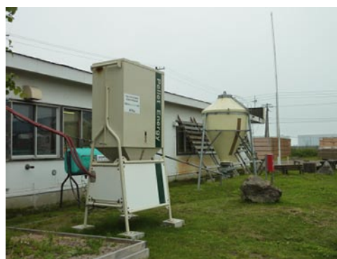
写真4 屋外サイロの外観 (手前：空送方式、奥：スクリーコンベア方式)
