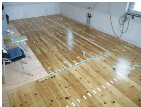
写真4 実験住宅での施工試験
