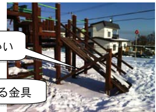
【筋かいの取付け状況】
