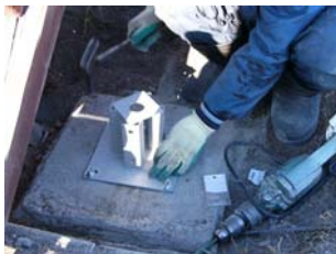
【補修金具取付け】
