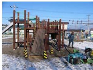
【補修部位（スロープ脇の支柱）】
