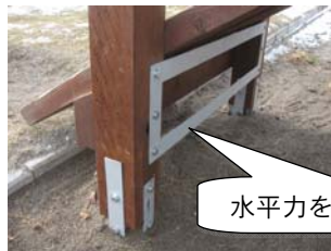
【埋め戻した状態】
