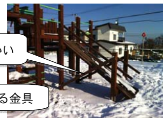
【筋かいの取付け状況】
