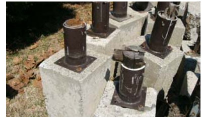
既存木製遊具柱脚の補修例
