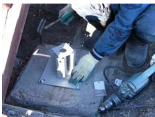
【補修金具取付け】
