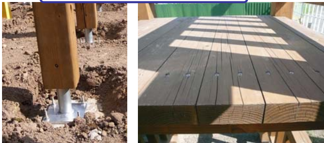
柱脚部金具の簡略化
