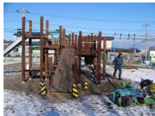
【補修部位（スロープ脇の支柱）】
