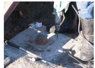
【後付けアンカー用穴あけ】
