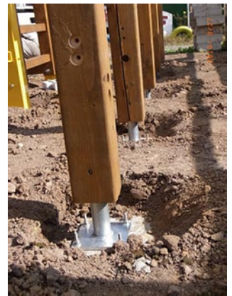
写真1 支柱脚部の金具
