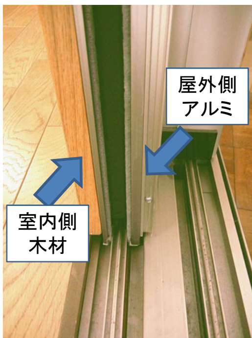
図3 クラッドタイプ木製サッシの例 (アルミクラッド)
