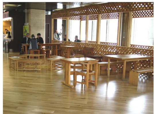
写真4 道庁1階ロビー床への敷設
