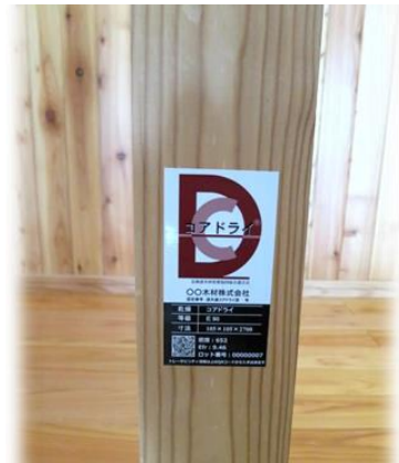
写真3 カラマツ心持ち管柱（コアドライ材）
