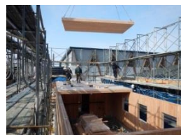
2階床パネルの施工
