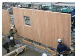
防腐処理土台と1階壁パネルの施工
