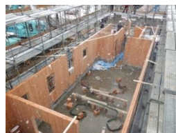
1階壁パネルの施工
