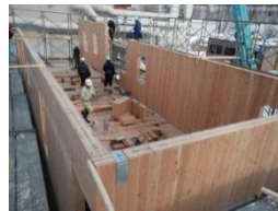
2階壁パネルの施工
