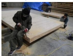
壁パネルの接合部加工
