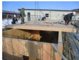
屋根パネルの施工
