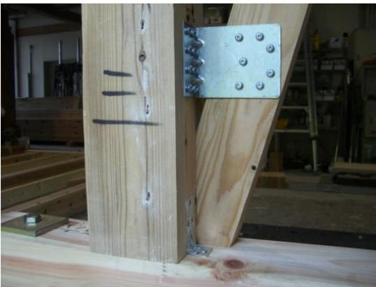
図4 ねじを用いた接合
