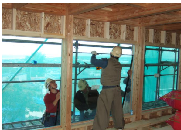
写真15 サッシの取り付けは5人掛かり
