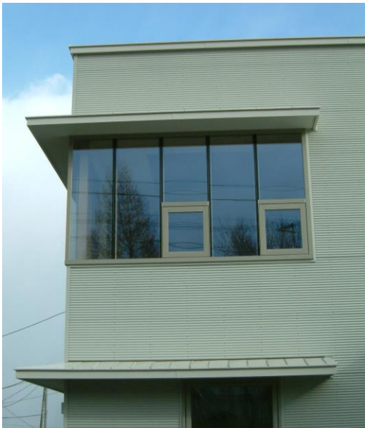
写真4 木製サッシを保護する庇
