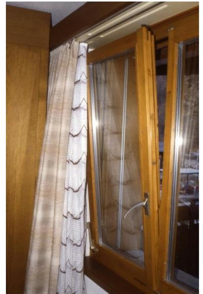
写真1 (左) 閉じた木製サッシ (中) 内開きの状態 (右) 内倒しの状態
