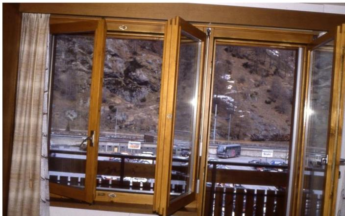
写真2 両開きの木製サッシとテラス戸の組み合わせ
