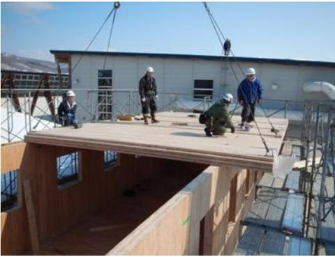
写真10 屋根パネルの施工
