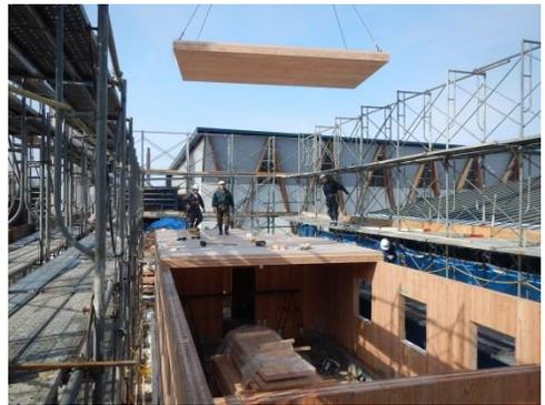
写真8 2階床パネルの施工
