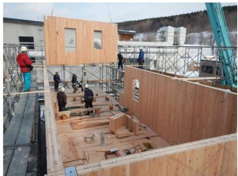
写真9 2階壁パネルの施工
