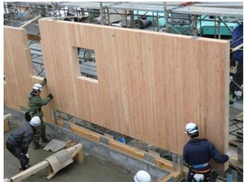
写真7 1階壁パネルの施工
