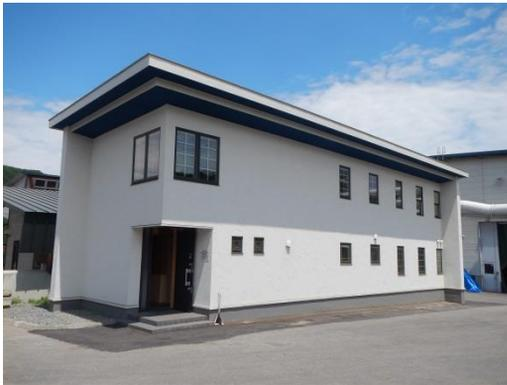
写真6 カラマツCLTを用いた建築物
