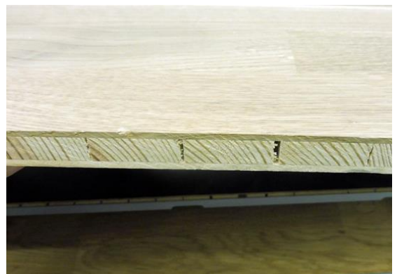
写真3 パーケットの断面
