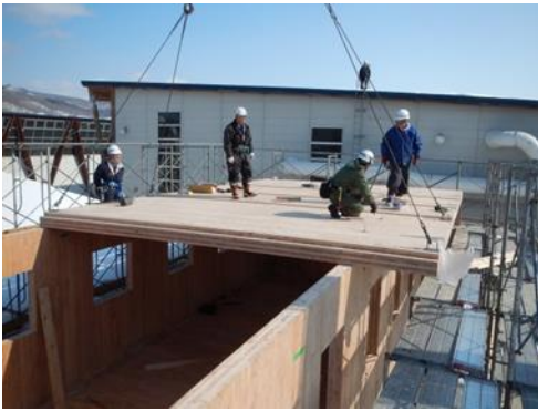
写真10 屋根パネルの施工
