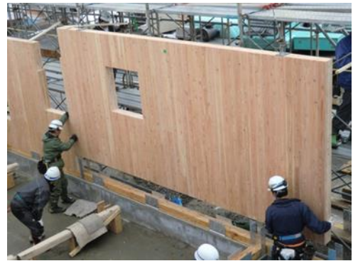
写真7 1階壁パネルの施工
