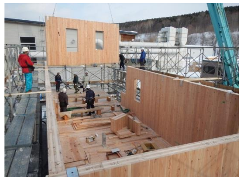
写真9 2階壁パネルの施工
