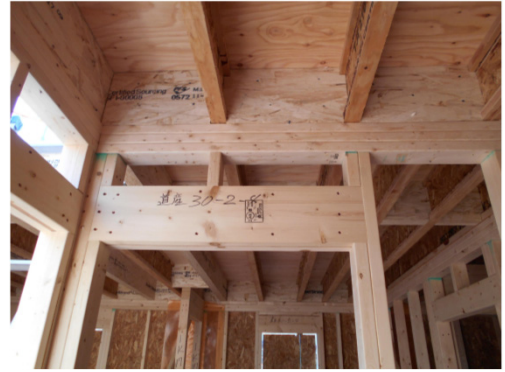
写真2 実際の住宅への試験施工（開口部まぐさ）
