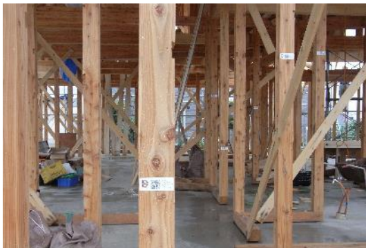
写真6 認証シールが貼られた柱
