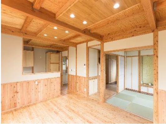
写真4 カラマツをあらわしで用いた住宅 (A邸, 旭川市東旭川)
